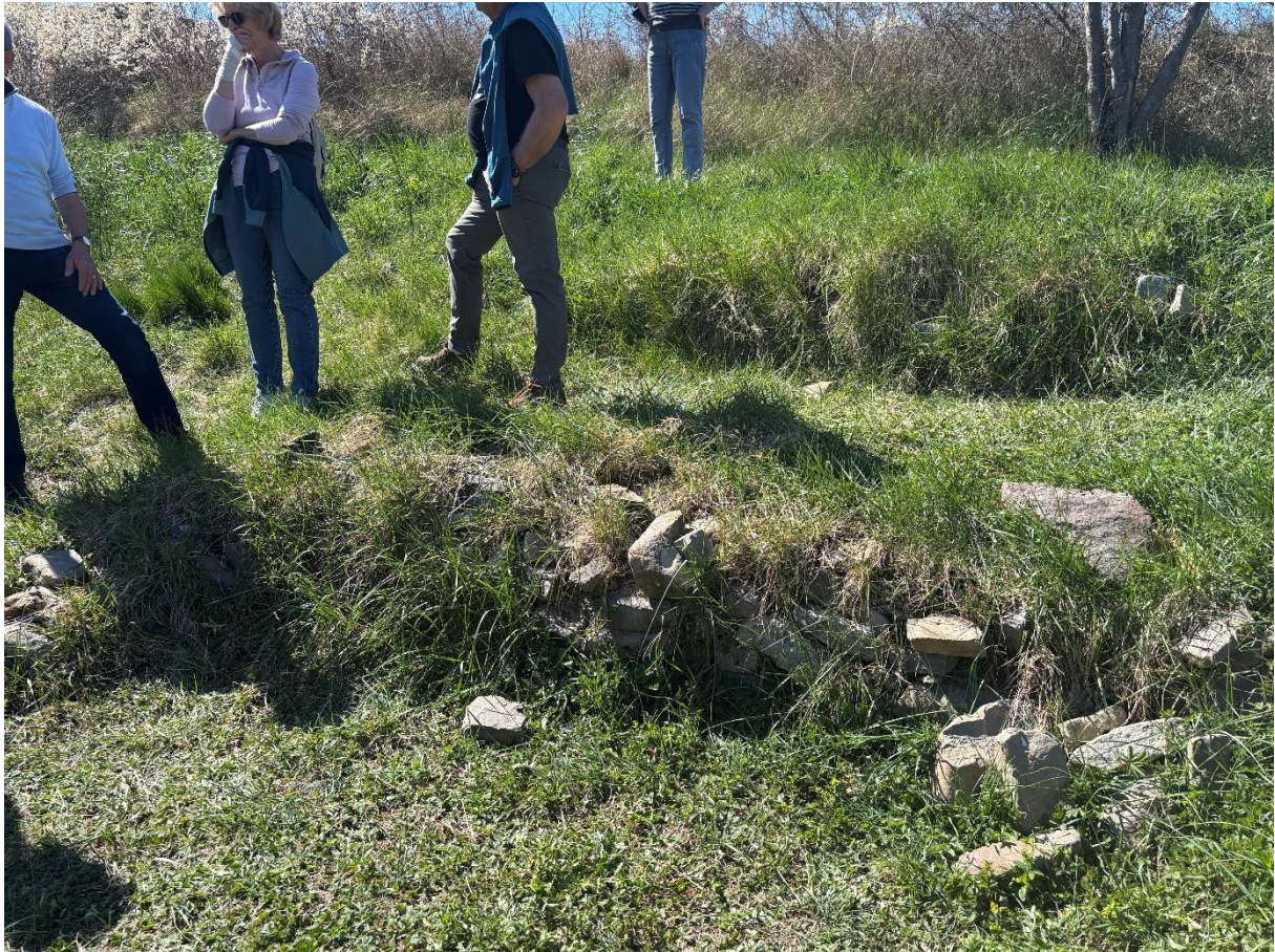
Fig. 01 : vue des murets avant restauration
