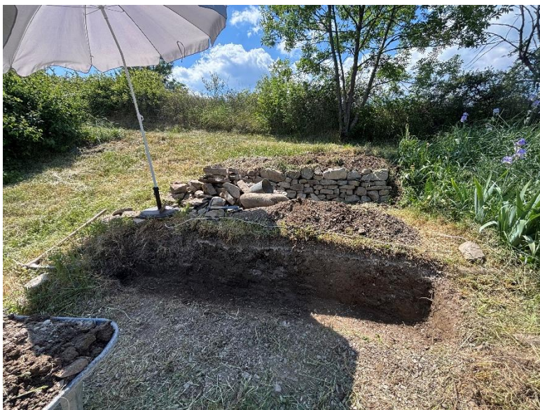
Fig. 10 : Le site en cours de travaux.
