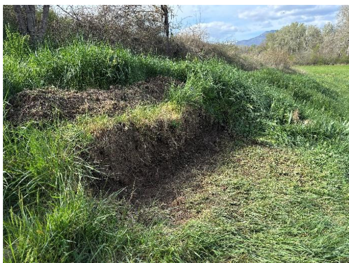
Fig. 05&06 : Terrassement des deux murs.
