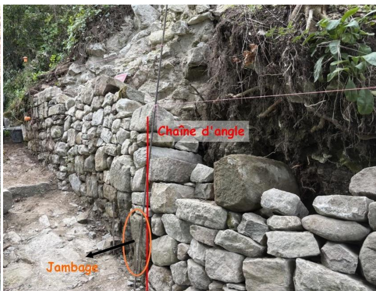
Fig. 07 à droite : En rouge, Démarcation entre le mur de soutènement en pierre sèche et celui lié au mortier de chaux.
