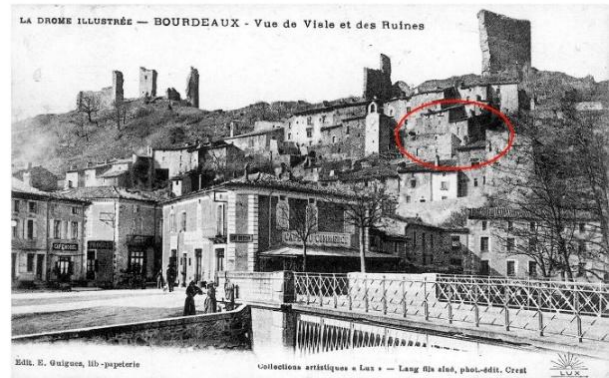
Vue du village et du pont sur le Roubion. ADD 100 Fi 167 Circa 1900 Habitations encore en place
