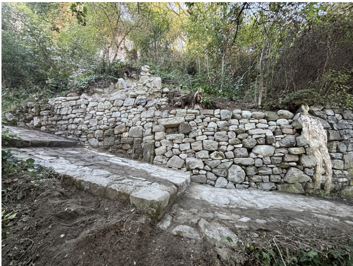
Fig. 01 : Vue du chantier fini.
