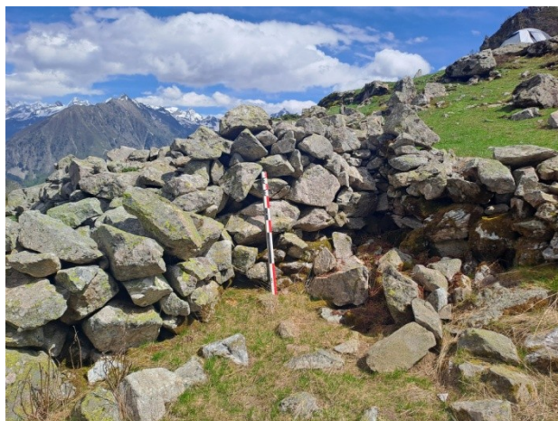
Fig. 04 : Vue de l'arrière du mur du fond, depuis le sud : jonction avec le mur de clôture Cl2 (à gauche) et le mur de soutènement stp5 (à droite) – avant travaux.
