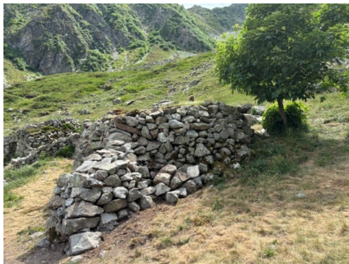
Fig. 04 : Vue de la partie nord, après travaux, dont le parement extérieur se prolonge en muret.
