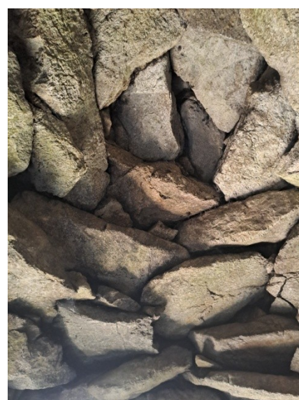
Fig. 04 : Vue de la fondation découverte pendant les travaux, au niveau de la chaîne d'angle nord-est de la cabane.
