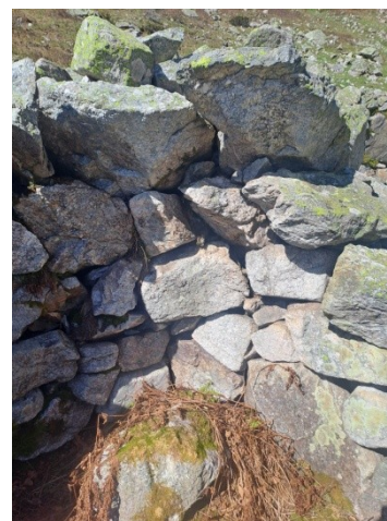
Fig. 04 : Parement du mur latéral est et pierres d'encorbellement réemployées en "contrefort" pour le mur Stp5.
