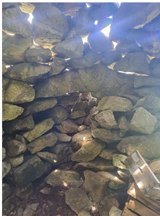
Fig. 05 : Vue du cul-de-four, depuis la porte d'entrée, et grandes dalles sommitales en contre-pendage.
