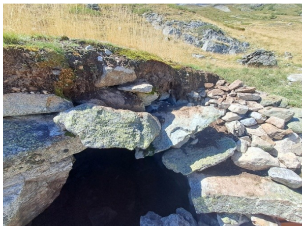
Fig. 03 : Vue de la jonction entre l'extrados encorbellé et la fourrure, derrière l'acrotère.
