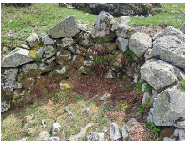
Fig. 05 : Vue du mur du fond en cul-de-four. Fig. 06 : Vue des pierres d'encorbellement au niveau du cul-de-four, depuis le sud.
