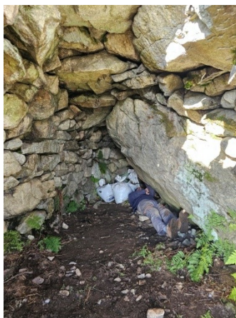
Fig. 03 : Vue de la jonction entre l'extrados encorbellé et la fourrure, derrière l'acrotère.
