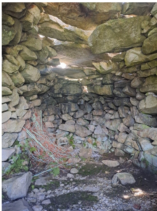
Fig. 05 : Vue du cul-de-four, depuis la porte d'entrée, et grandes dalles sommitales en contre-pendage.
