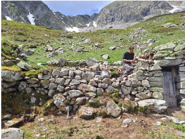
Fig. 2.30 (ci-dessus) : Reprise des acrotères arrière.
