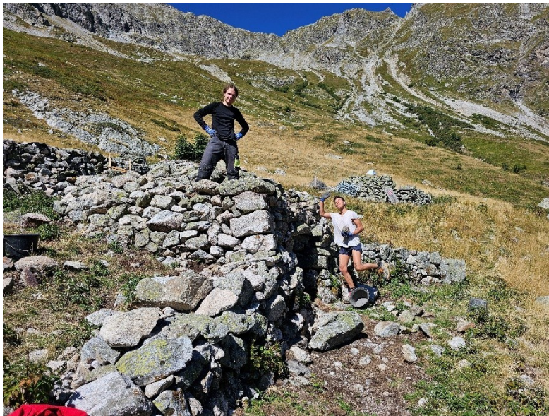
Fig. 2.61 (à gauche) : Lors des travaux.
