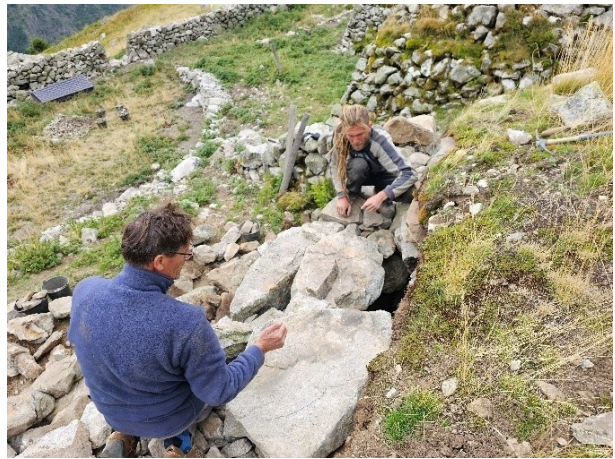
Fig. 2.38 (à gauche) : restauration des jambages de la porte (pendant les travaux).
