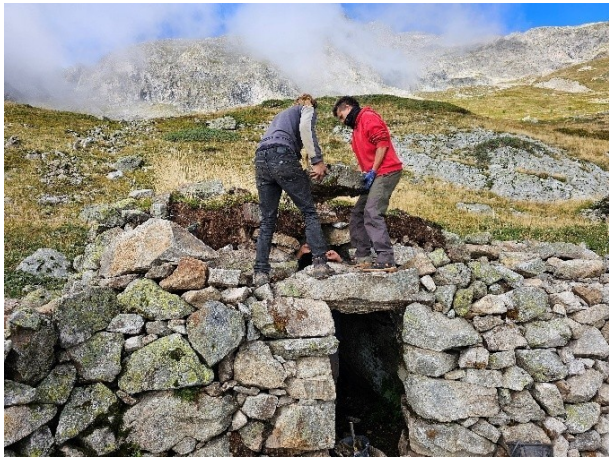
Fig. 2.40 & 2.41 : Reconstruction de l'encorbellement.
