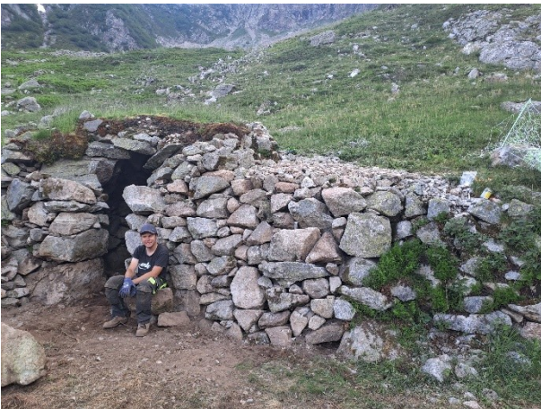
Fig. 2.91 & 2.92 (ci-dessus) : Mur restauré et drain de ceinture restitué.
