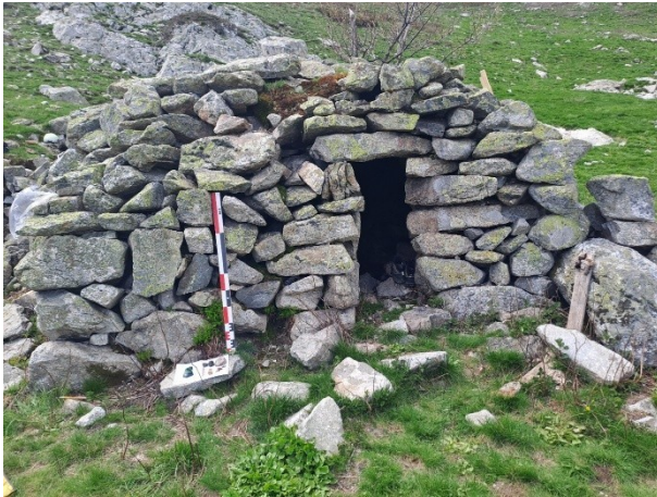
Fig. 2.44 (à gauche) : Façades est avant travaux
