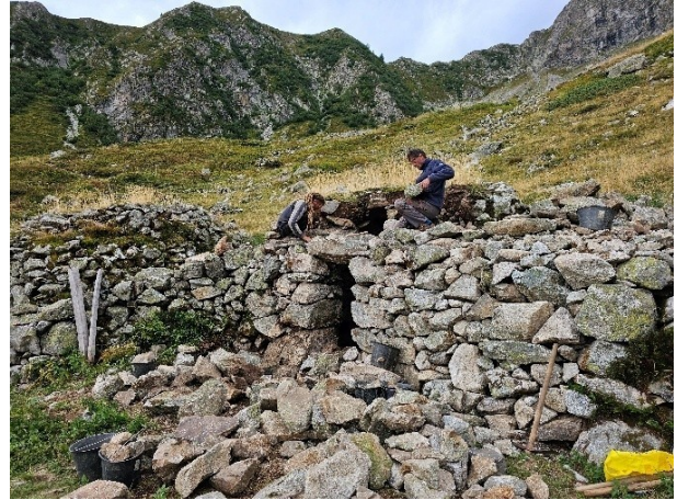
Fig. 2.38 (à gauche) : restauration des jambages de la porte (pendant les travaux).
