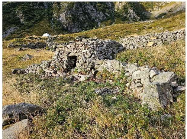
Fig. 2.64 (à droite) : Reprise des soutènements latéraux.
