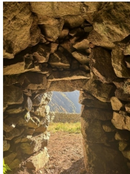
Fig. 2.35 (ci-dessus, à gauche) : Vue de la cabane restaurée en septembre 2025.
