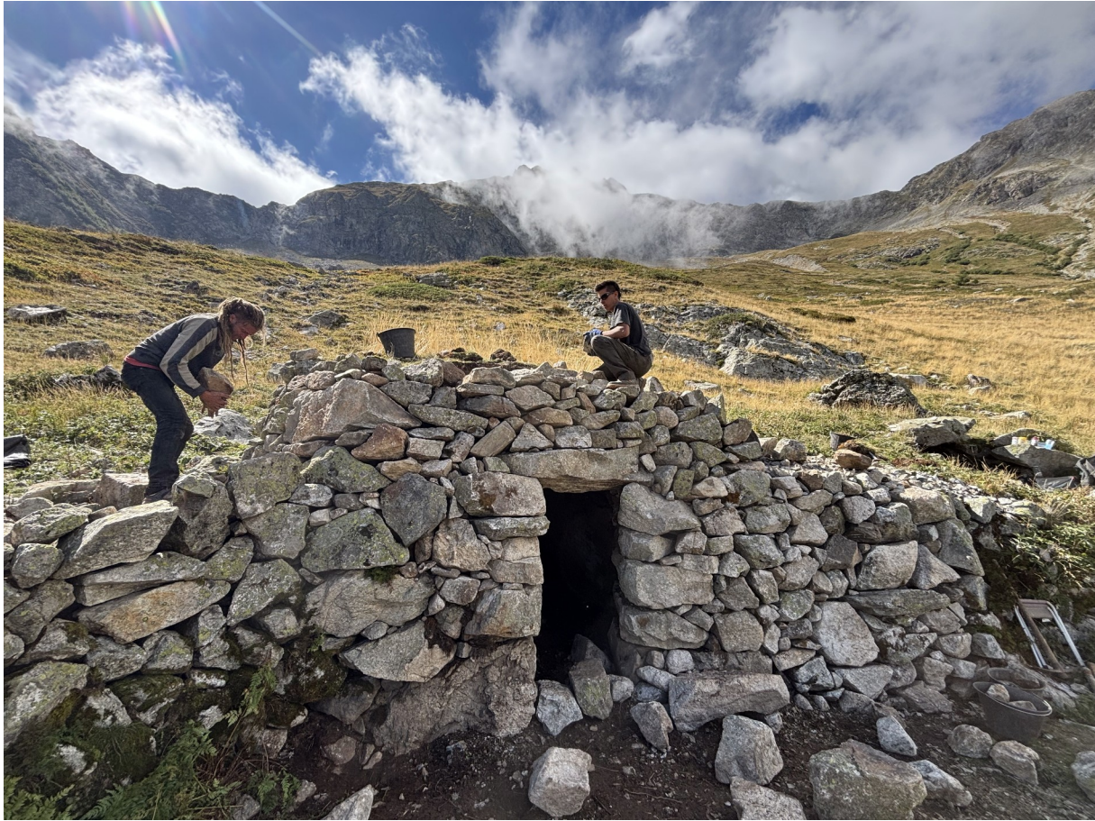
Fig. 01 : Vue de la restauration de l'une des cabanes du site.
