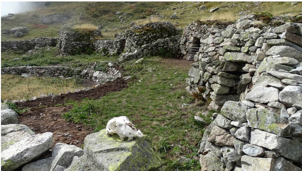
Fig. 2.50 (ci-dessous) : Au premier plan, la cabane C6 restaurée depuis l'entrée nord de l'espace central (© J. - P. Catelan).
