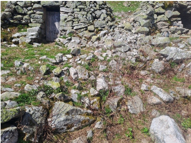
Fig. 2.95 (ci-dessus à gauche) : Le mur de soutènement stp3 avant travaux.
