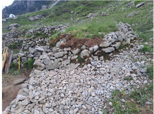
Fig. 2.89 & 2.90 (ci-dessus) : Terrassement et découverte du drain de ceinture.
