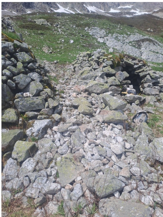
Fig. 2.72 & 2.73 : La rampe avant travaux.
