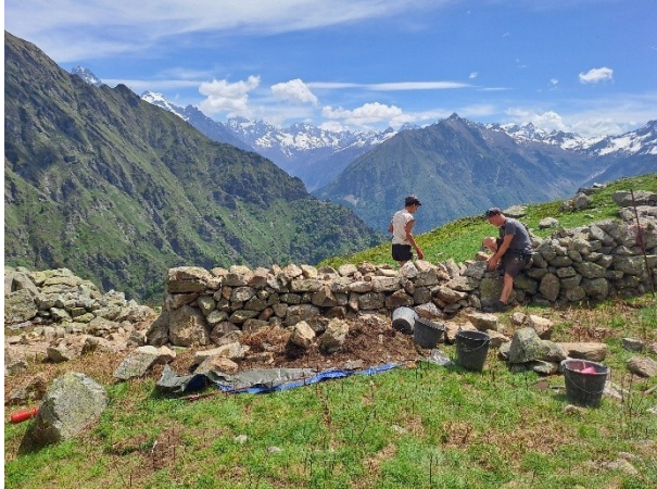
Fig. 2.81 à 2.83 (ci-dessus et ci-contre) : Restauration du mur de clôture.
