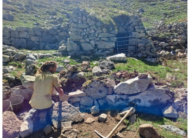
Fig. 2.99 & 2.100 (ci-dessus) : Restauration du mur de soutènement stp2.
