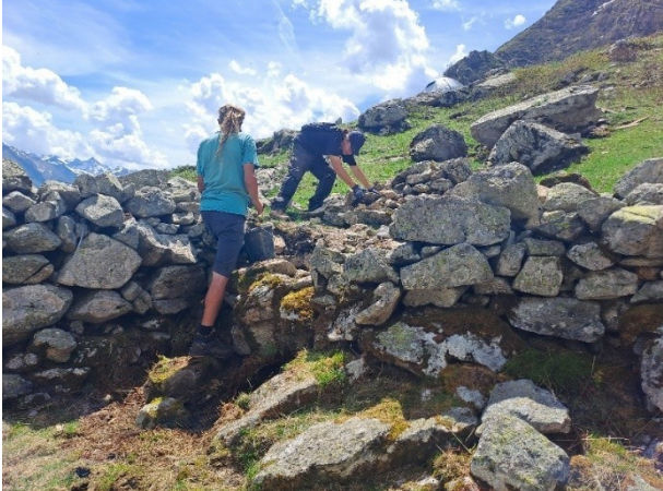
Fig. 2.07 & 2.08 (ci-dessus et ci-contre) : Reprises de appareillages des cabanes C1 et C2.
