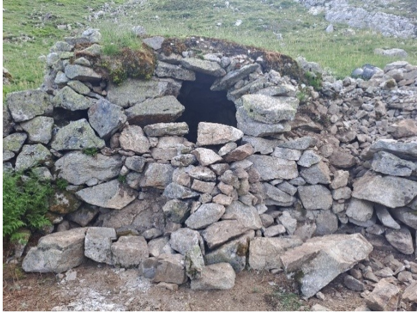
Fig. 2.38 (à gauche) : restauration des jambages de la porte (pendant les travaux).
