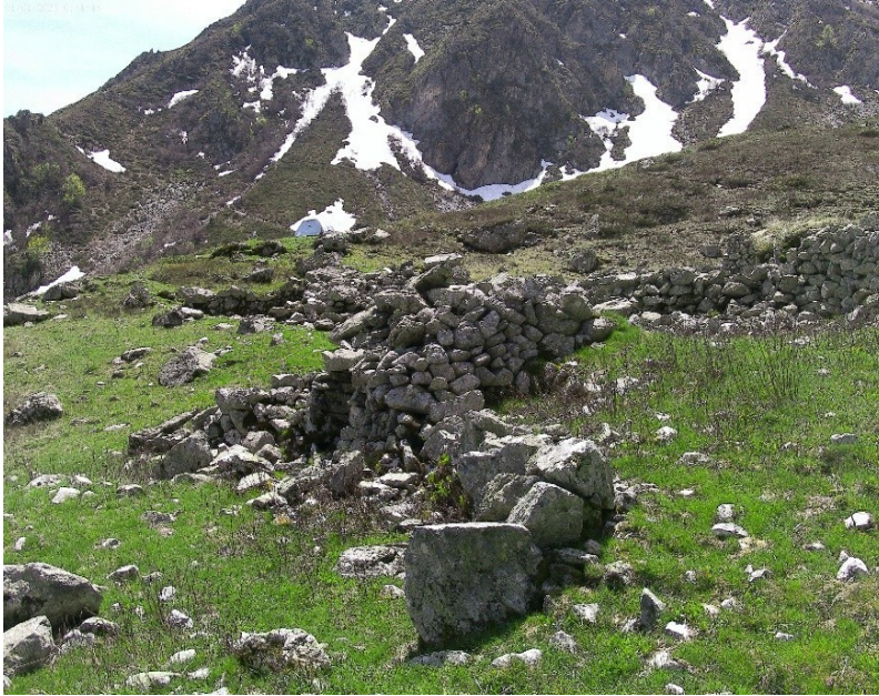
Fig. 2.59 (à gauche) : La cabane, avant travaux.
