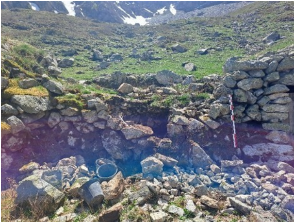
Fig. 2.28 (ci-dessus) : Purge de la jonction des murs sud, Stepe3 et de la façade principale est.
