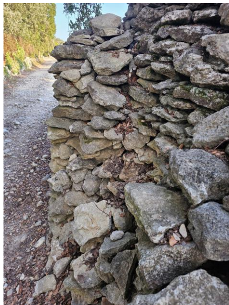
Fig. 09 : Effondrement de la façade est.
