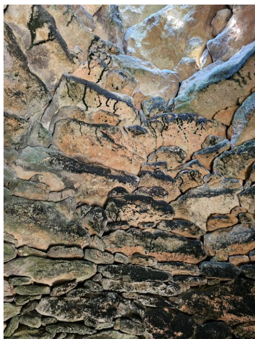
Fig. 21 : L'encorbellement refermé, vue de l'intérieur.
