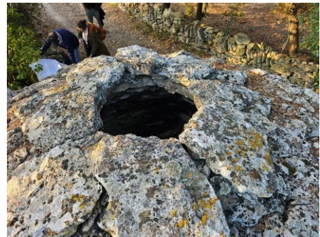
Fig. 08 : Lacune en haut de l'encorbellement.
