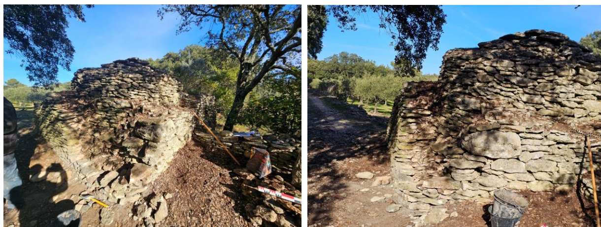
Fig. 14 & 15 : Purge de l'angle sud-ouest.
