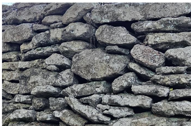
Fig. 06 : appareillage de la cabane
