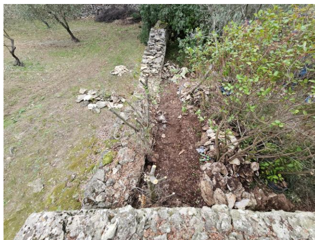
Fig. 20 : vue du terrassement du mur de clôture depuis le haut de la cabane.
