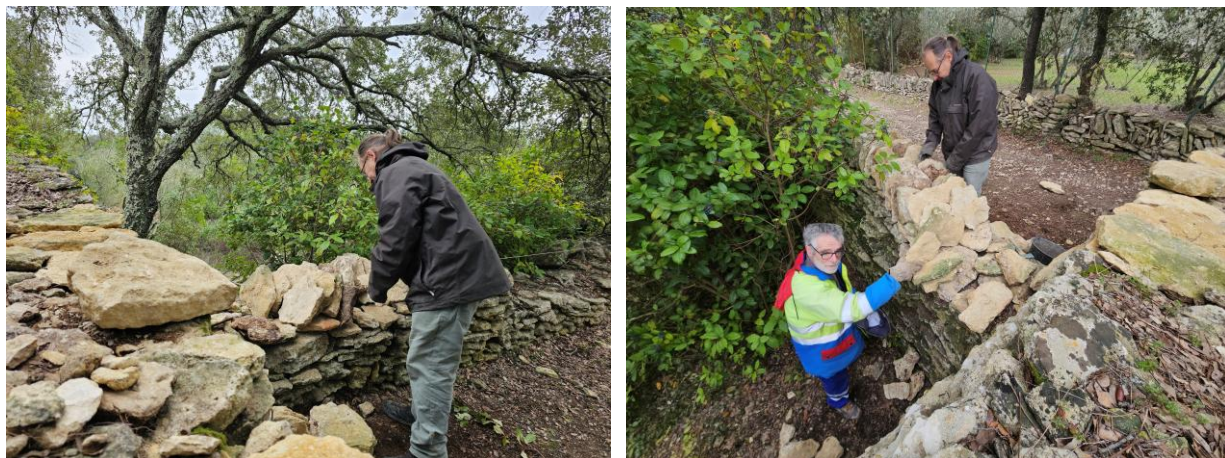
Fig. 26 & 27 : restauration du mur de soutènement du chemin.
