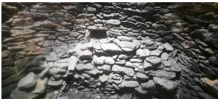
Fig. 12 : Stock de pierres rangées à l'intérieur de la cabane.
