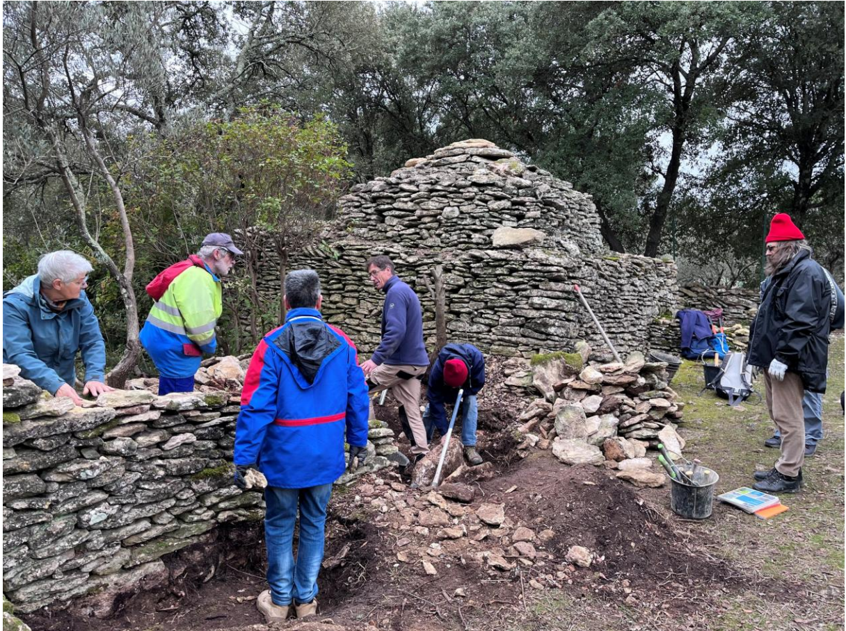
Fig. 01 : Restauration du mur de clôture.
