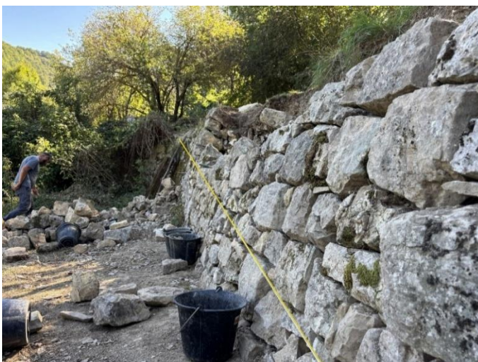
Fig. 05 : Pierres du débouché de la rampe faisant office de fondations et ayant basculé.
