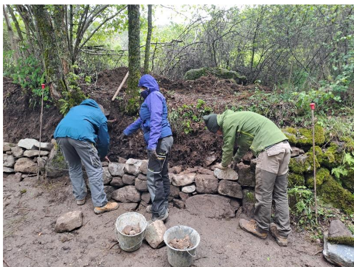
Fig. 11 & 12 : le mur en cours de restauration
