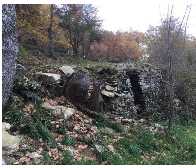
Eboulement du mur de soutènement comprenant la cabane
