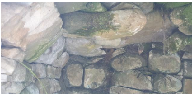
Pierres initiant l'encorbellement
