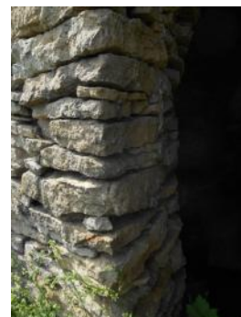
Chaînage d'angle de l'entrée
