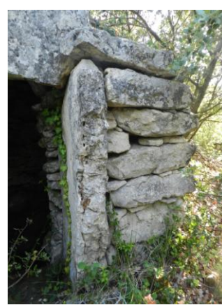
Monolithe jambage de l'ouverture
