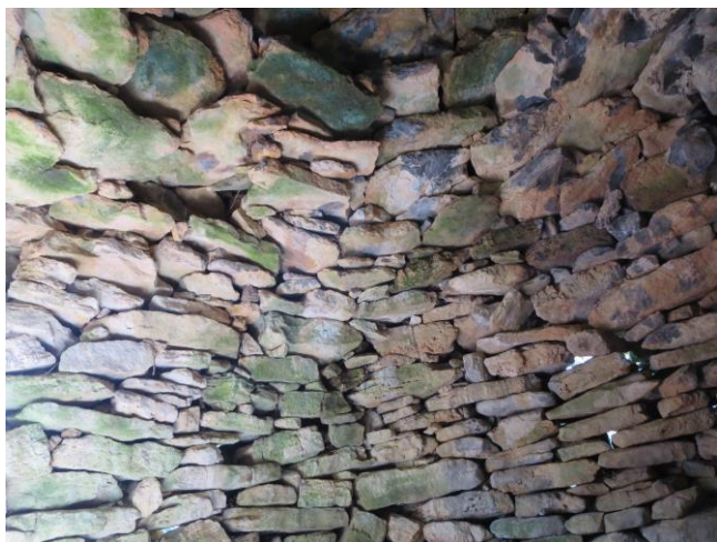
Appareillage des murs et encorbellement Vue du passage entre les deux cellules et assises
