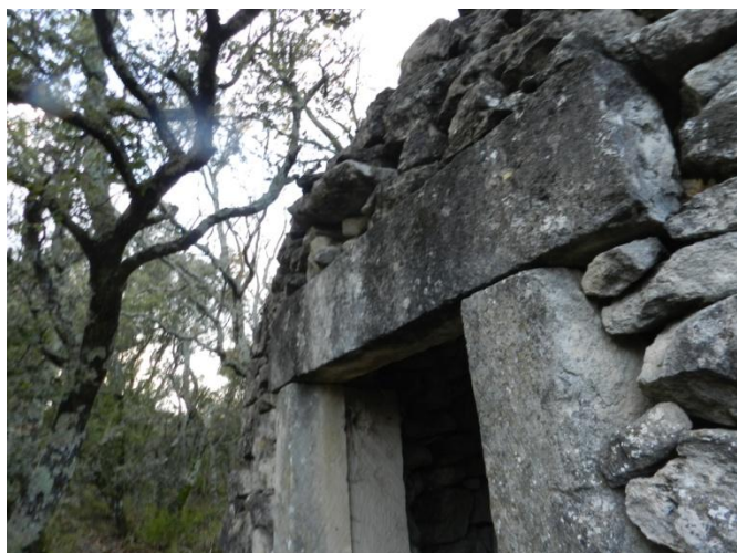
Fig. 03 : porte sud et pierre formant larmier ; Fig. 04 : foyer ; Fig. 05 : jambage ouest
