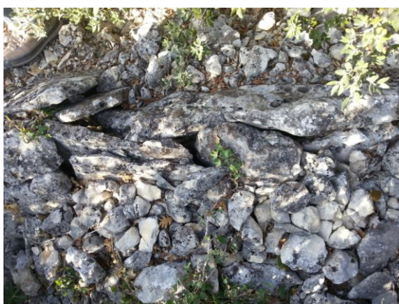
Vue de dessus des dalles posées en bâtières et du tas de charge
