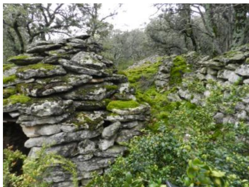
Toiture en encorbellement
