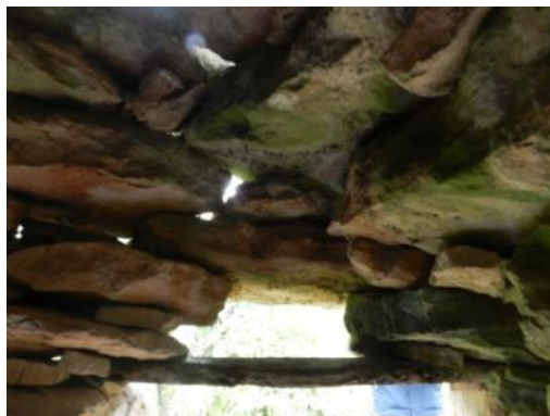
Détail intérieur triple linteau
