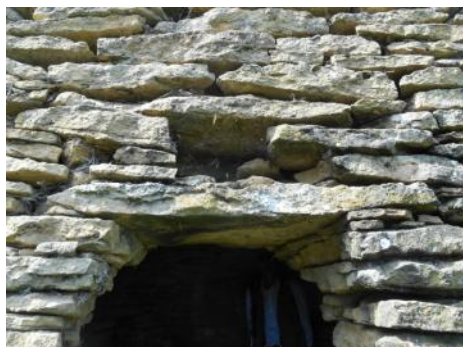
Détail du linteau double et lucarne
