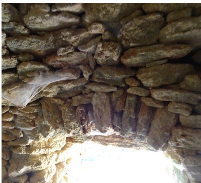
Vue de l'arc de décharge et des feuillures de l'ouverture depuis l'intérieur
