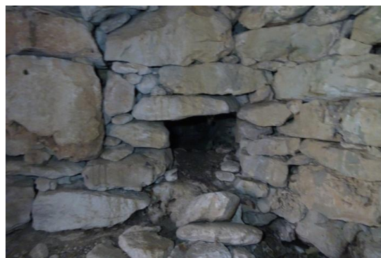
Fig. 05 : mur int. nord, granulométrie variable, dallage, niche. / Fig. 06 : niche / galerie en partie int. ouest.
