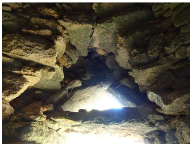
Détail de l'arc de décharge et des jambages de l'ouverture
