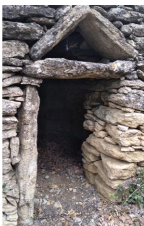
Détail de l'arc de décharge et des jambages de l'ouverture
