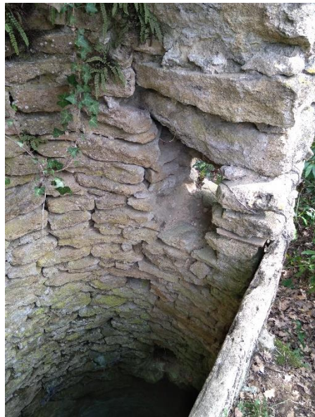
Fig. 04 : Réserves traversantes dans la maçonnerie
