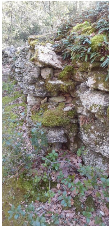
Rupture d'appareillage
