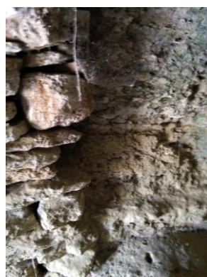
Raccord intérieur mur/roche
