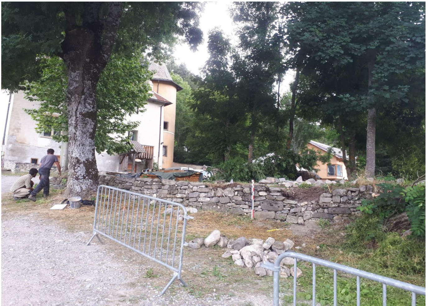
Fig. 18 : le mur de soutènement du canal en cours de restauration au niveau de la coupe A (Fig.4 p.3)
