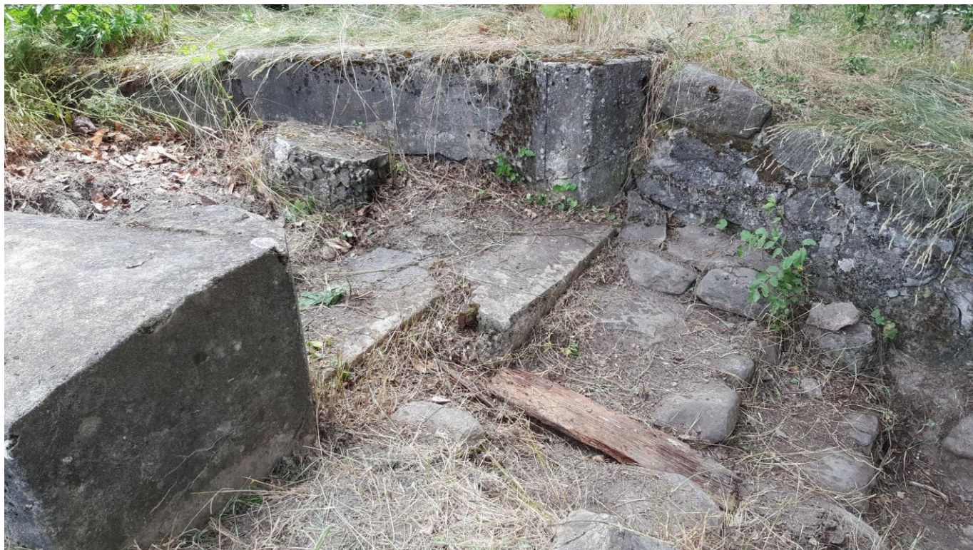
Fig. 12 : vue détail de l'abée, double martellière, planche de bois et ressauts en calade (Damien Laurent)
