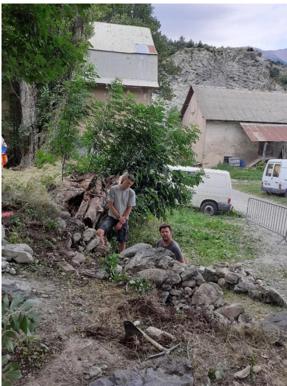
Fig. 25 & 26 : Mur de soutènement Sud -démontage du mur et reprise de la brèche. Appareillage selon l'existant et couronnement
