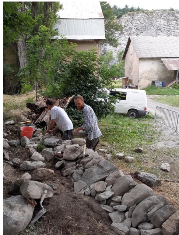
Fig. 25 & 26 : Mur de soutènement Sud -démontage du mur et reprise de la brèche. Appareillage selon l'existant et couronnement
