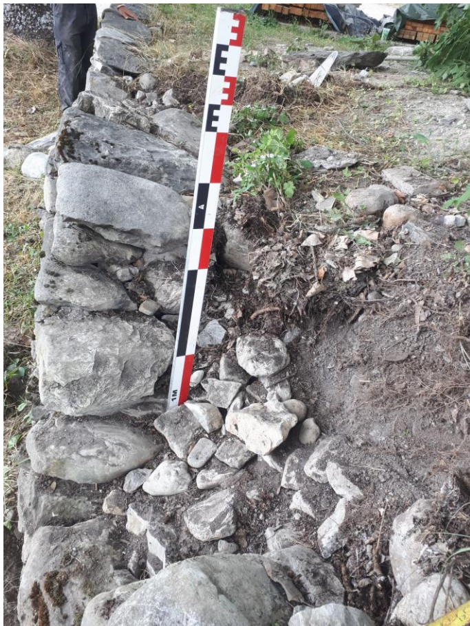
Fig. 19 à 21 : vue de face et en coupe du soutènement au niveau de la coupe A
