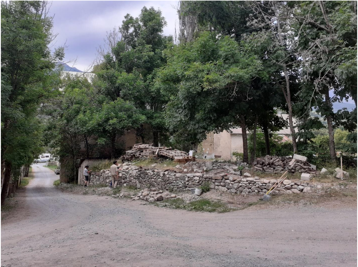
Fig. 24 : Mur de soutènement Nord - réfection de la ligne d'arête et du couronnement du mur
