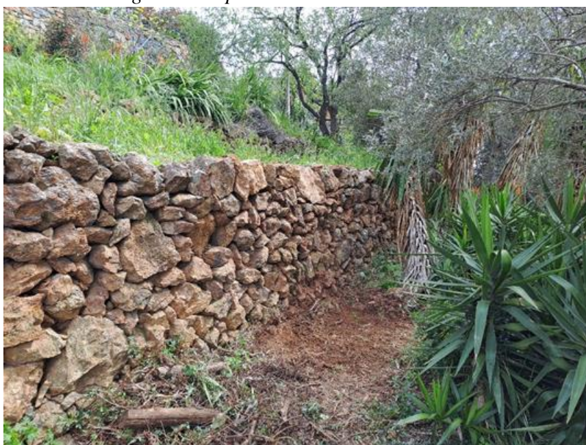
Fig. 12 : brèche du soutènement de la terrasse 8 restaurée
