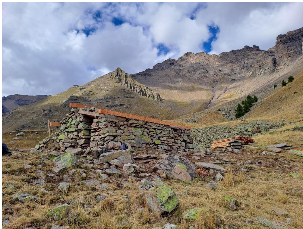
Fig. C1 : Restauration des appareillages de la cabane achevés, avant pose de la couverture
