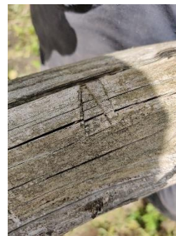
Fig. 6-1 : marque d'outil sur la faîtière de la cabane des Clots
