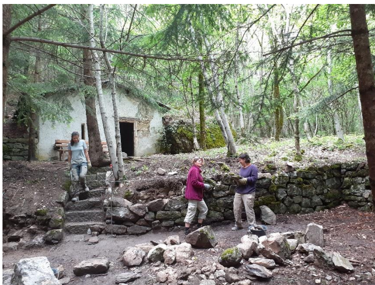
Fig. 20 : restauration du soutènement du haut de l'esplanade.
