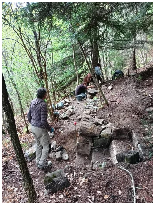
Fig. 32 & 33 : montage et finition du mur de soutènement du bas de la platebande (images Joël Catinot et Romain Cluzel).
