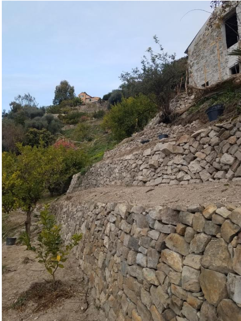
Fig. 1 : les soutènements restaurés.
