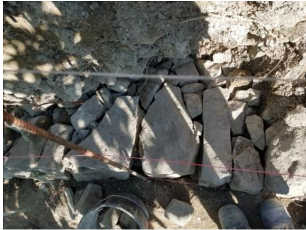
Fig. 14 : Reprise des fondations et de leur pendage. Fig. 15 : Blocage arrière sur une petite largeur de mur.
