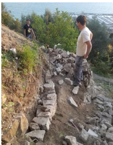
Fig. 29 : Reprise des fondations et courbe
