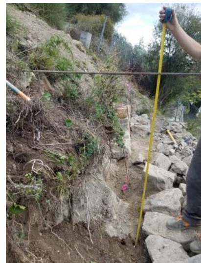
fig. 19 : Décaissement
