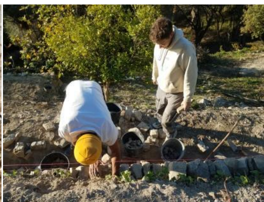
Fig. 32 : Appareillage au-dessous du talus
