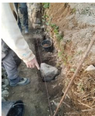
Fig. 31 : Reprise des fondations
