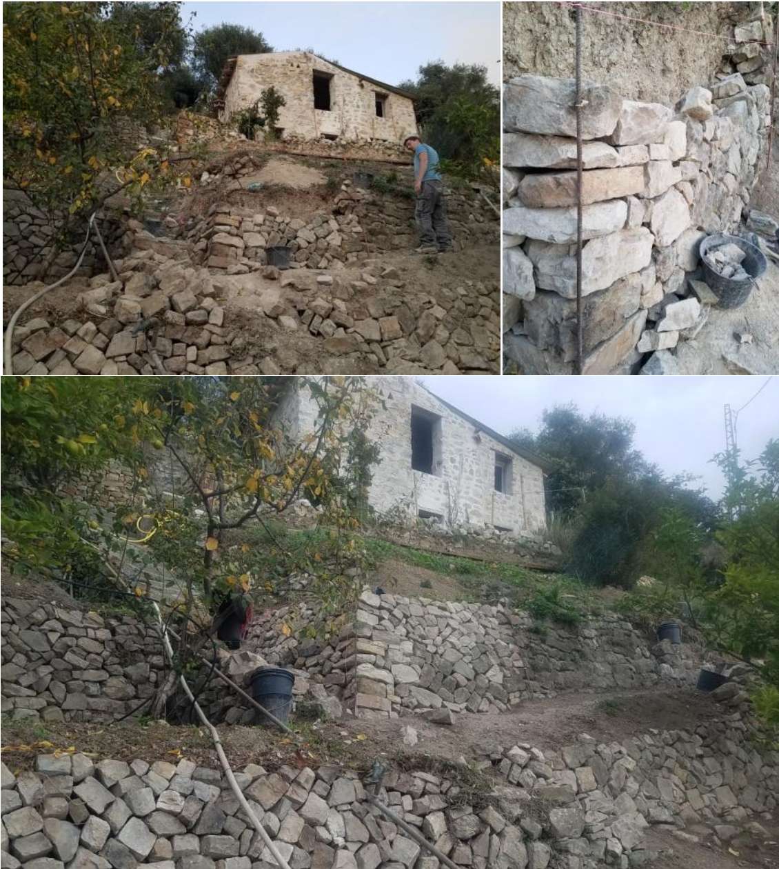
Fig. 24 à 26 : Reprise de l'angle côté escalier
