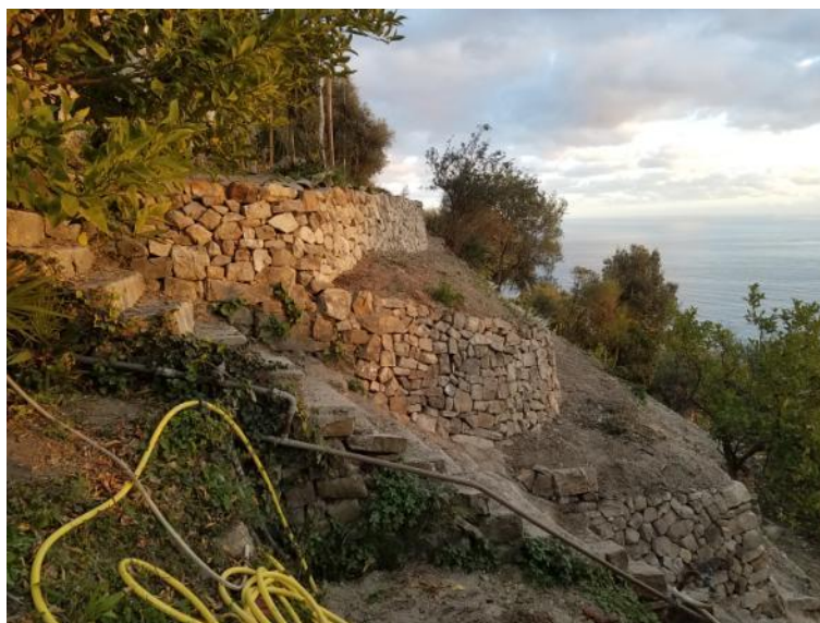
Fig. 39 : vue Est travaux finis
