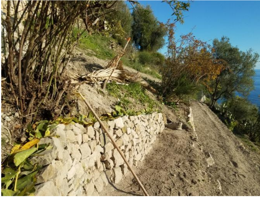
Fig. 33 : Accès conservé au niveau de l'escalier volant du mur 2
