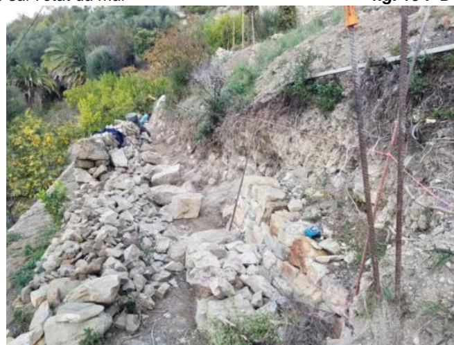
Fig. 20 : Préparation-déblai de la terrasse
