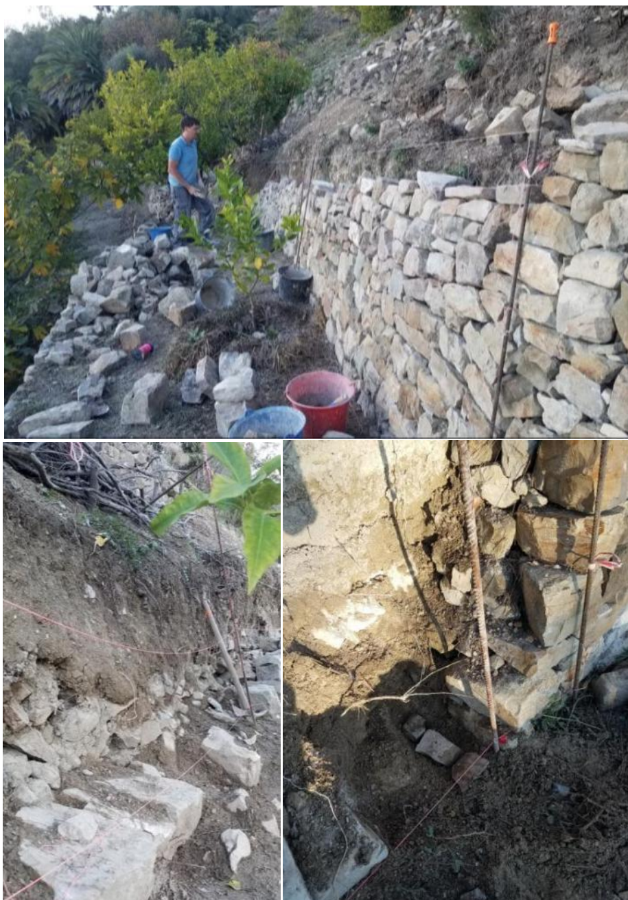
Fig. 11 à 13 : Etat du mur après décaissement et terrassement
