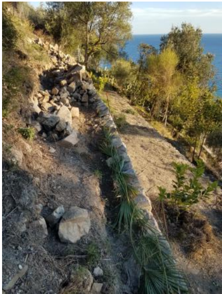
Fig. 16 : Compactage de la terre et pose de "géotextile" Fig. 17 : Terrassement et talus au-dessus du couronnement
