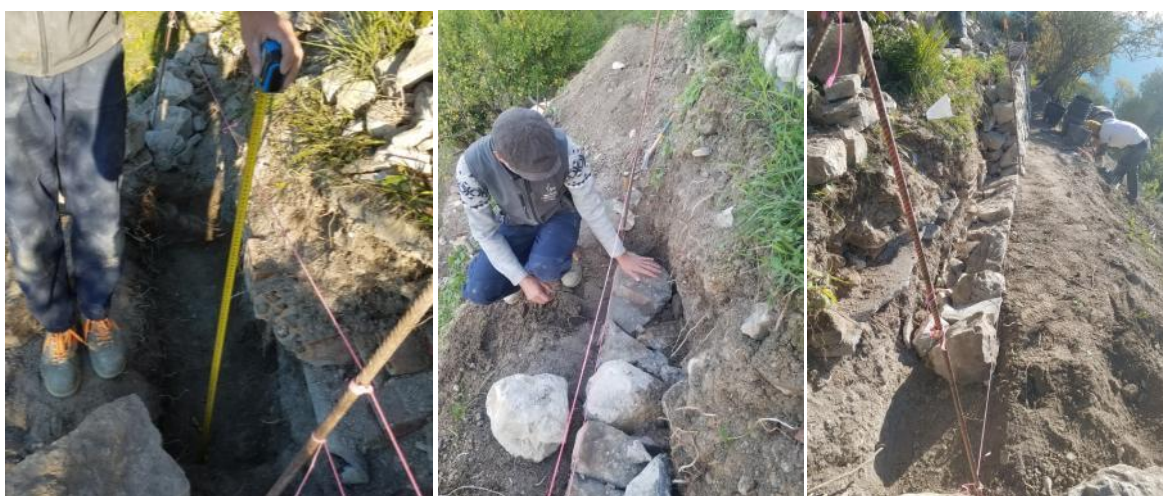
Fig. 34 à 36 : Recherche du bon sol, fondations et appareillage
