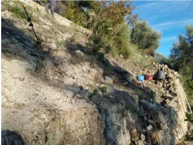
Fig. 27 : Etat d'origine de l'accès
