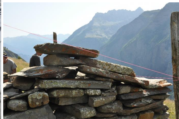
Fig. 32 : vue du pignon nord, ardoises témoignant de l'ancienne couverture de lauze. Le cordeau indique la réhausse actuelle
