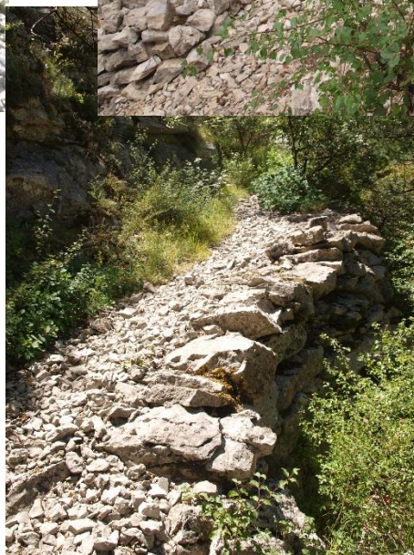
Fig. 124 : création de soutènement pour contenir l'éboulement (TM).
