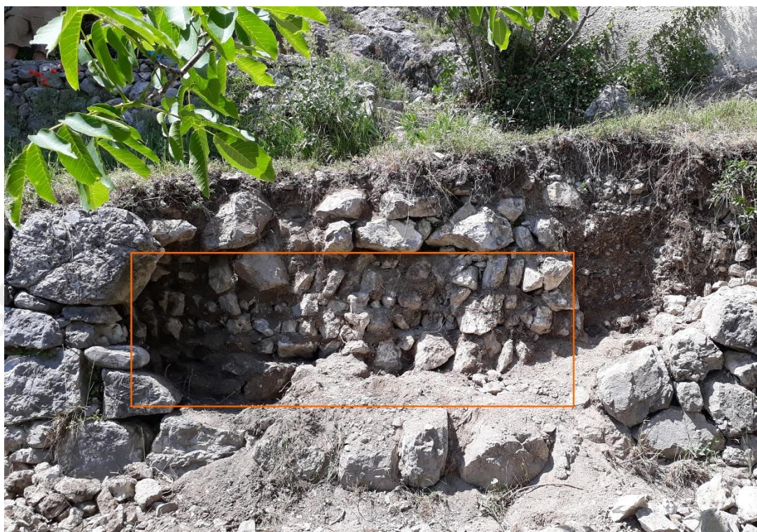
Fig. 184 : vue du parement ancien à l'arrière de la maçonnerie du soutènement.
