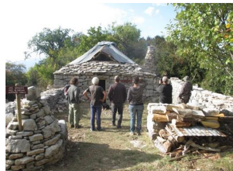
Fig. 148 : Charpente posée, mise en place des tôles et de couchettes en mezzanine (F.Jolivet).
