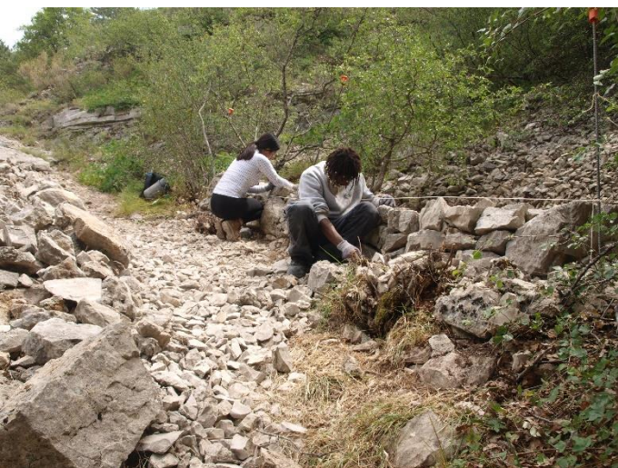
Fig. 114 à 119 : vues pendant le chantier international (114-JN, 115 à 119-TM). Fig. 120 : croquis descriptif du dispositif de contrepoids-rambarde.
