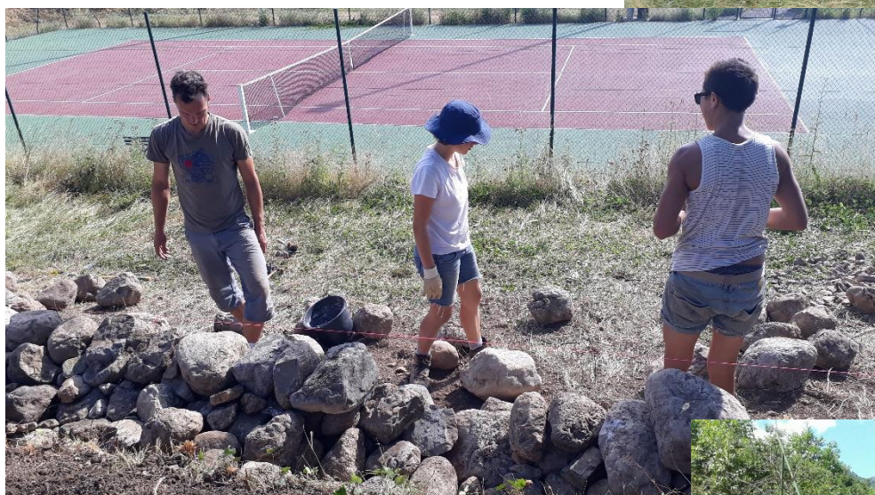
fig. 30 à 33, de haut en bas : démontage des appareillages ruinés (SB -sauf JN fig.32) ; chantier terrassé (SB) ; mur en reconstruction (SB) ; mur fini (SB).
