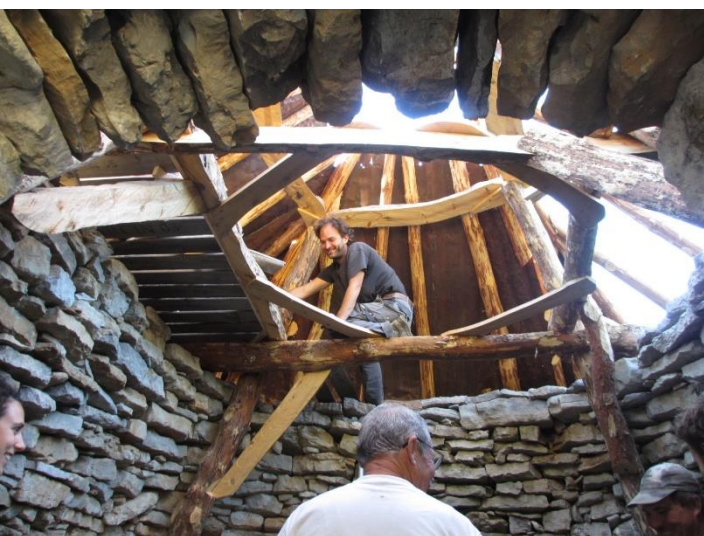
Fig. 148 : Charpente posée, mise en place des tôles et de couchettes en mezzanine (F.Jolivet).
