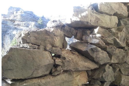
Fig. 192 : à gauche effondrement imminent
