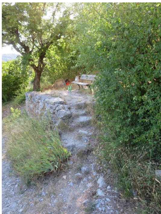
Fig. 169 & 170 : état avant travaux.
