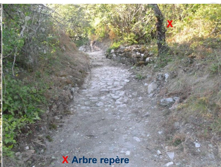
Fig. 81 : La rue avant intervention.
