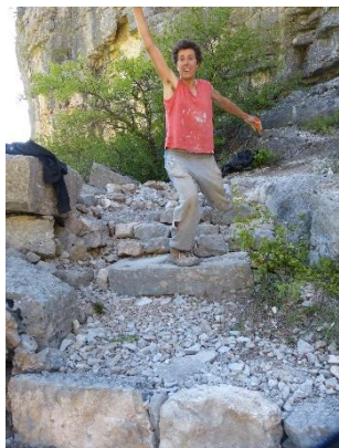
Fig. 106 & 108 (TM) ; 107 & 109 (JN) : restauration des soutènements et mise en place de marches.
