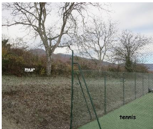
fig. 26 : le mur de soutènement du champ de pommier.
