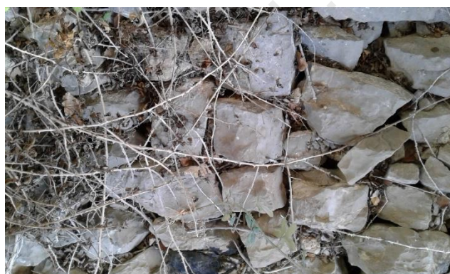
Fig. 198 : mur au sol, vue verticale
