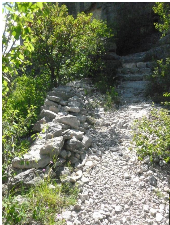
Fig. 121, 122 : Restauration de soutènement
