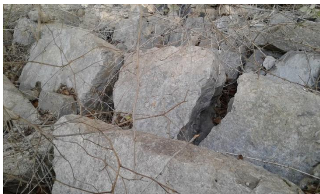
Fig. 197 : mur au sol, vue de 3/4
