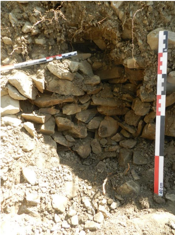
Fig.4 : Drain appareillé à l'arrière de l'appareillage brèche 2
