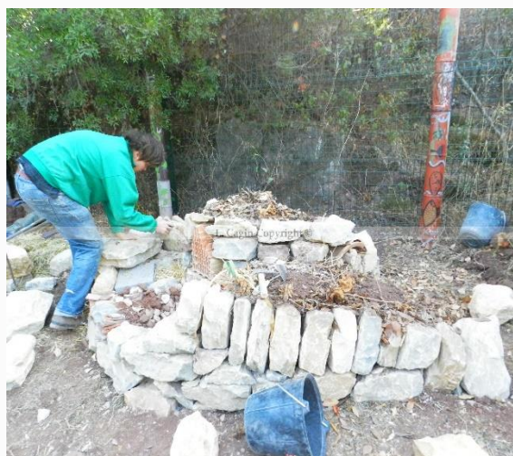
Fig.24 –la structure minérale de la spirale est presque terminée
