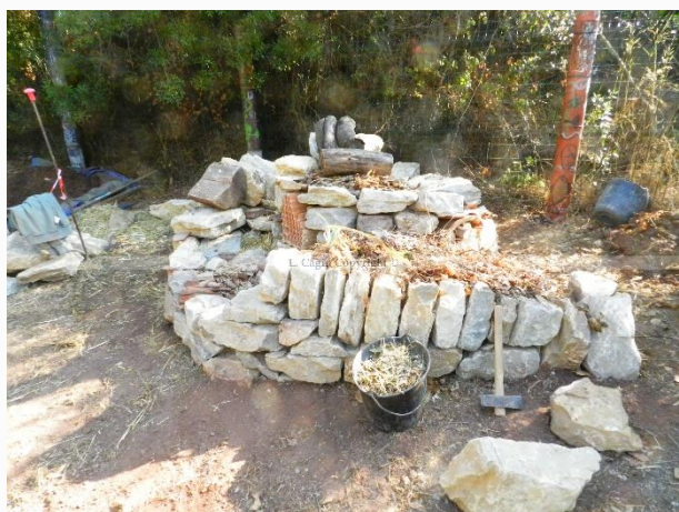
Fig.2 – la spirale en construction
