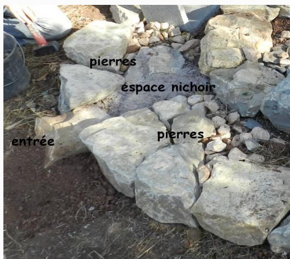
Fig.10 –il ne reste plus qu'à recouvrir le nichoir avec une pierre plate qui s'appuie sur les pierres latérales. L'espace nichoir sera praticable.
