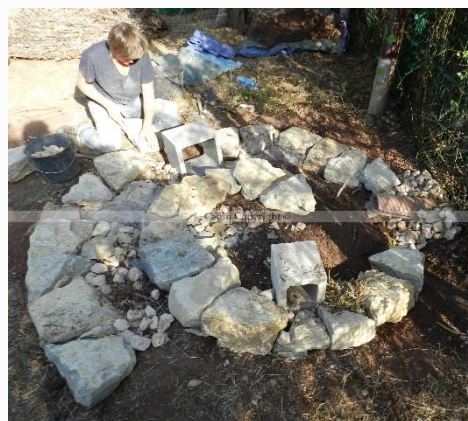
Fig.19 - la première rangée de pierres de fondations
