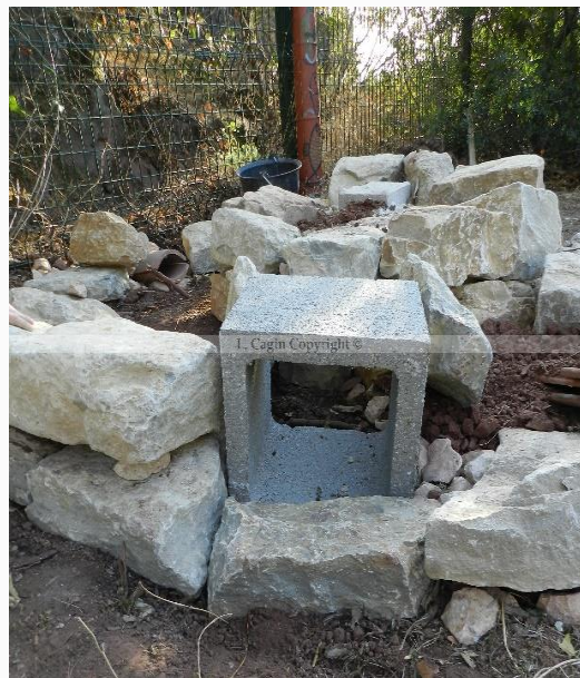
Fig.12 –un conduit de cheminée fera l'affaire et évitera un travail compliqué d'appareillage
