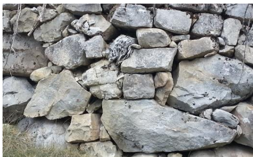
Appareillage « d'origine » avec léger pendage latéral
