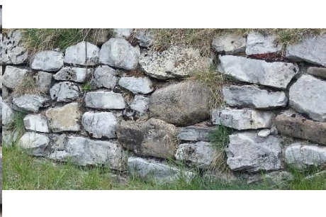
Restauration au liant appareillage régulier assisé
