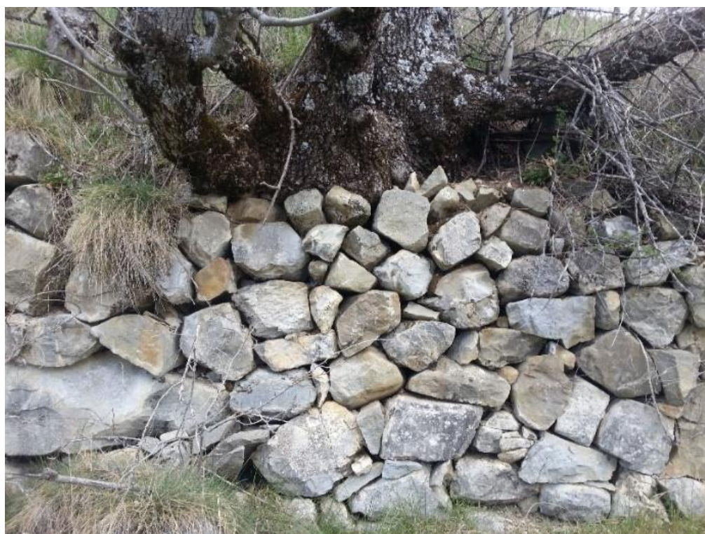
Détail d'appareillage mariant grès et calcaire
