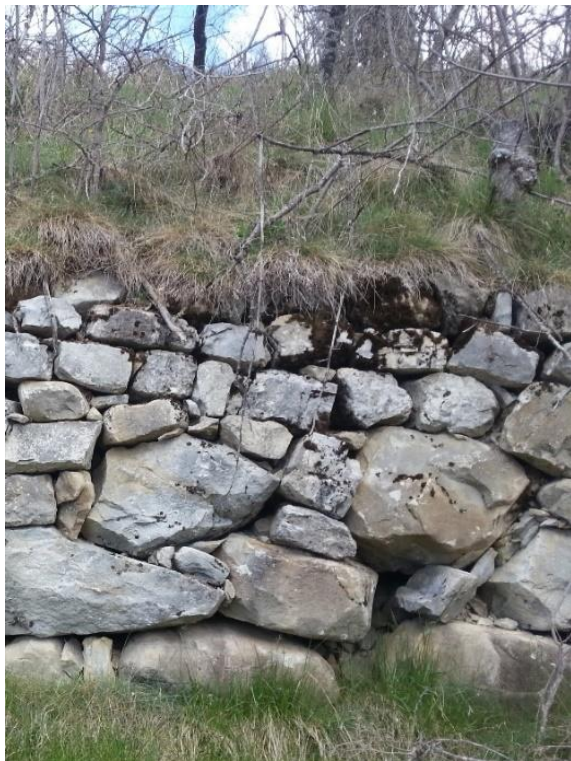
Mur de soutènement taluté à la sortie du village
