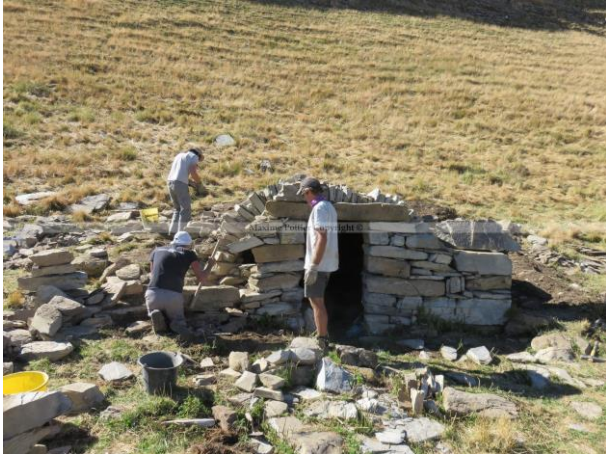
Fig.13 Fenestron et son linteau en équilibre suite à l'affaissement (M. Pottier)
