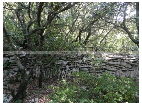
fig.19, appareillage assisé / fondation sur chant
