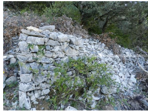
Fig. 13 Clapier parementé en bout de mur
