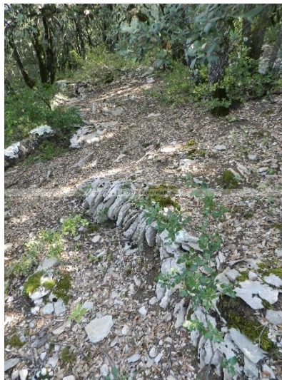
Fig.18 fondation sur chant
