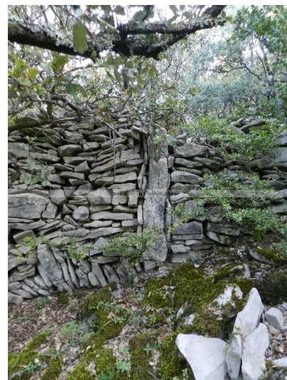
Fig. 24 pierre dressée dans le mur
