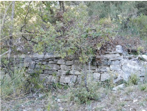
Fig.11 Appareillage aux lignes d'assises soignées
