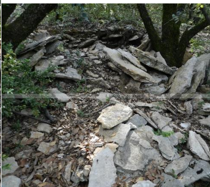
Fig.21 arrière de mur
