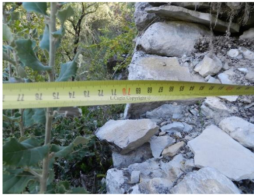
Fig.15 70cm d'épaisseur à mi-hauteur
